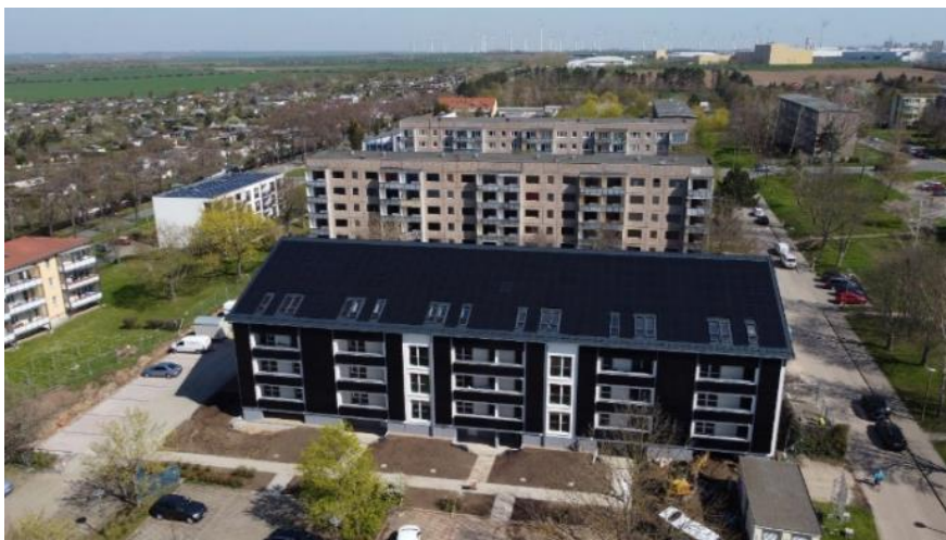
Abb. 9 Gestern alter DDR-Plattenbau in Aschersleben, heute hochgradig energieautarkes Mehrfamilienhaus mit 22 Wohneinheiten.
