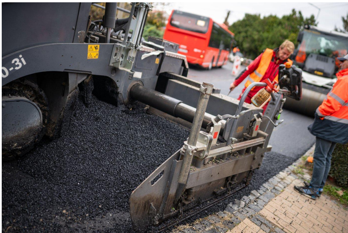
Abb. 4 Detail vom Einbau des SMA-Mischguts mit Reneso Fibers – im Hintergrund fährt ein ÖPNV-Bus durch die Gemeinde Malinovo. Bild: SCBSK
