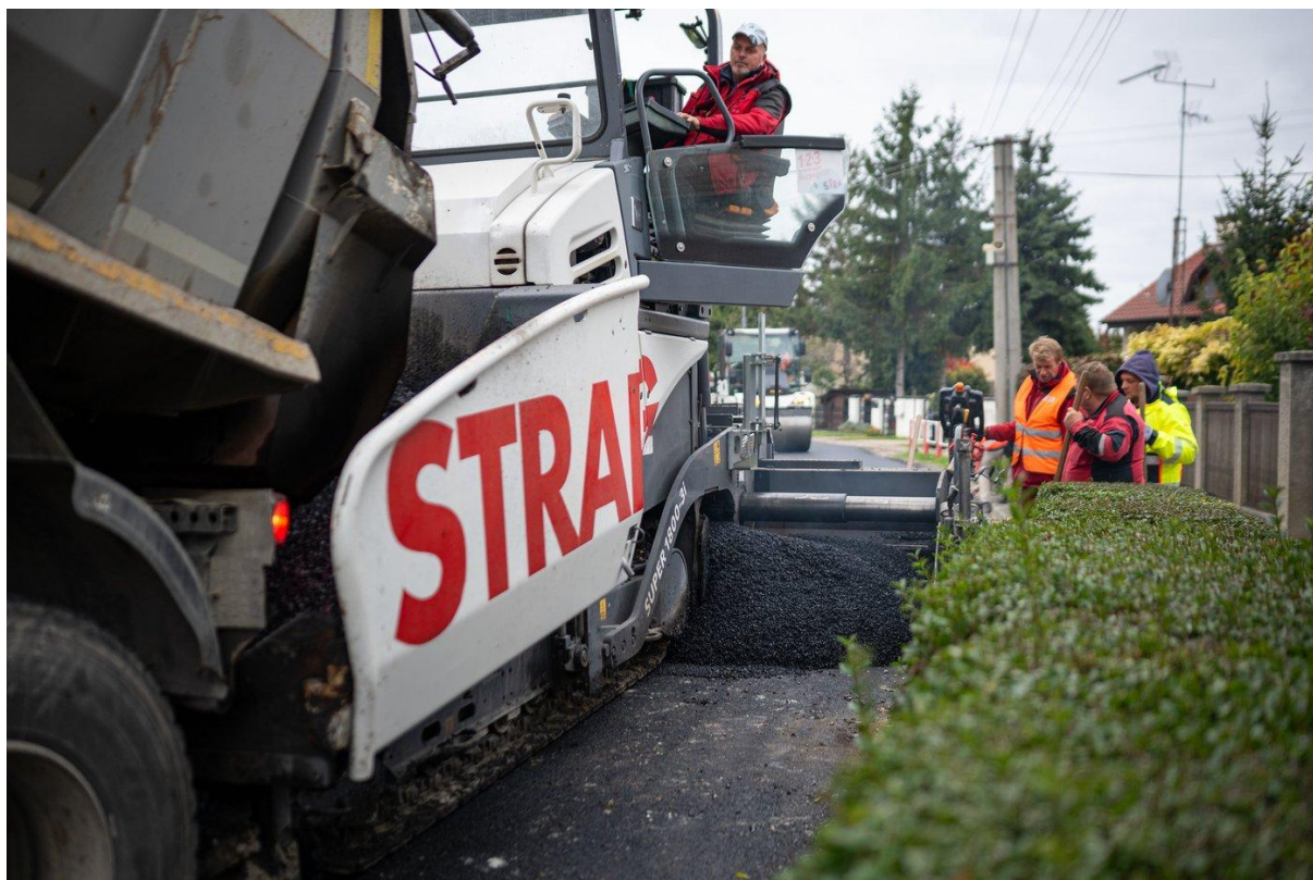
Abb. 3 Asphaltfertiger STRABAG Super 1800-3i beim Einbau von SMA-Mischgut mit Reneso Fibers-Zusatzstoff, Straße II/121 Malinovo, 27. 10. 2025. Bild: SCBSK
