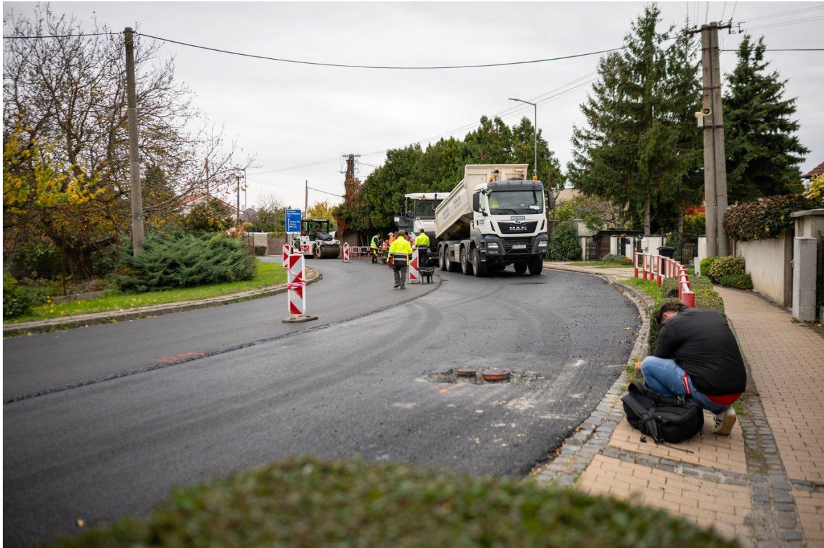
Abb. 5 Gesamtansicht des sanierten Abschnitts der Straße II/121 in Malinovo während der Verdichtung der SMA-Mischung. Bild: SCBSK
