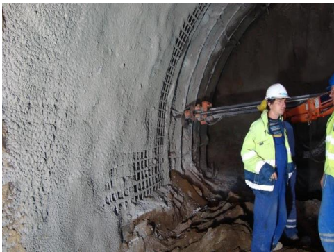
Obr. 5 Montáž kotevních šroubů
