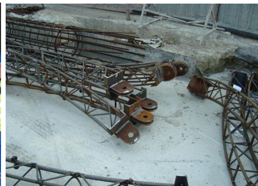
Obr. 6 Рáмы дрáтённого плетива с клóубовými spoji
