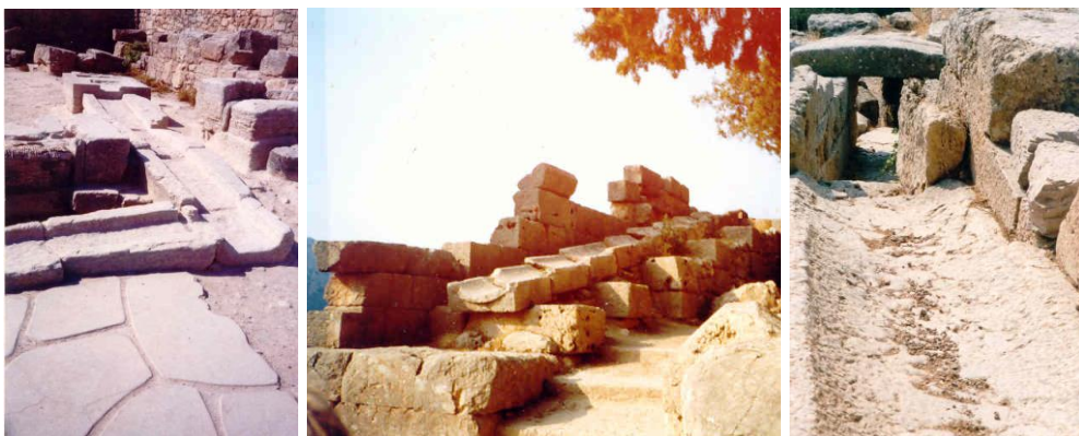
Obr. 2 – 4 Kamenné potrubí z paláce Knóssos na Krétě pro zachytávání a svody na dešťovou vodu pro lázně v paláci
