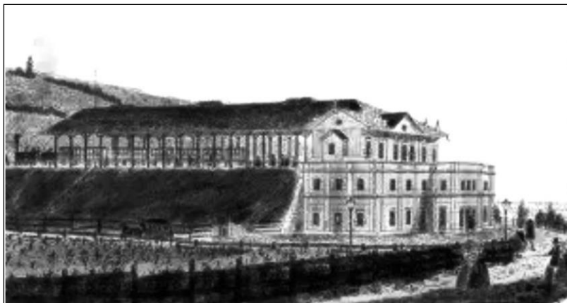
Obr. 1 Prvá budova železničnej stanice z roku 1848, dobová rytina
