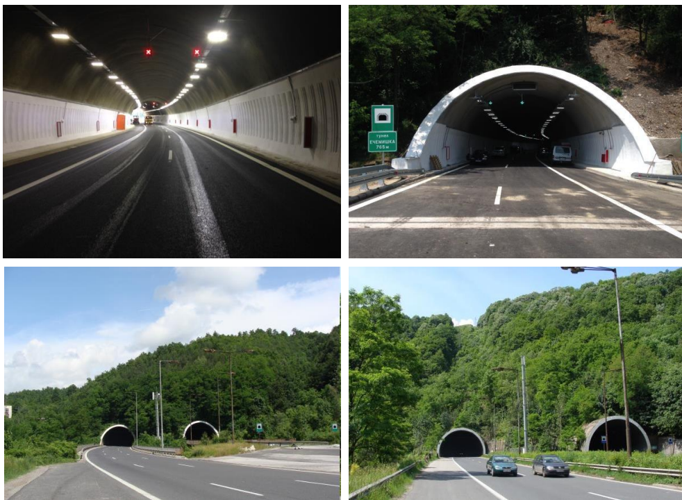
Obr. 7 Dokončena oprava tunelů dálnice „Hemus“
