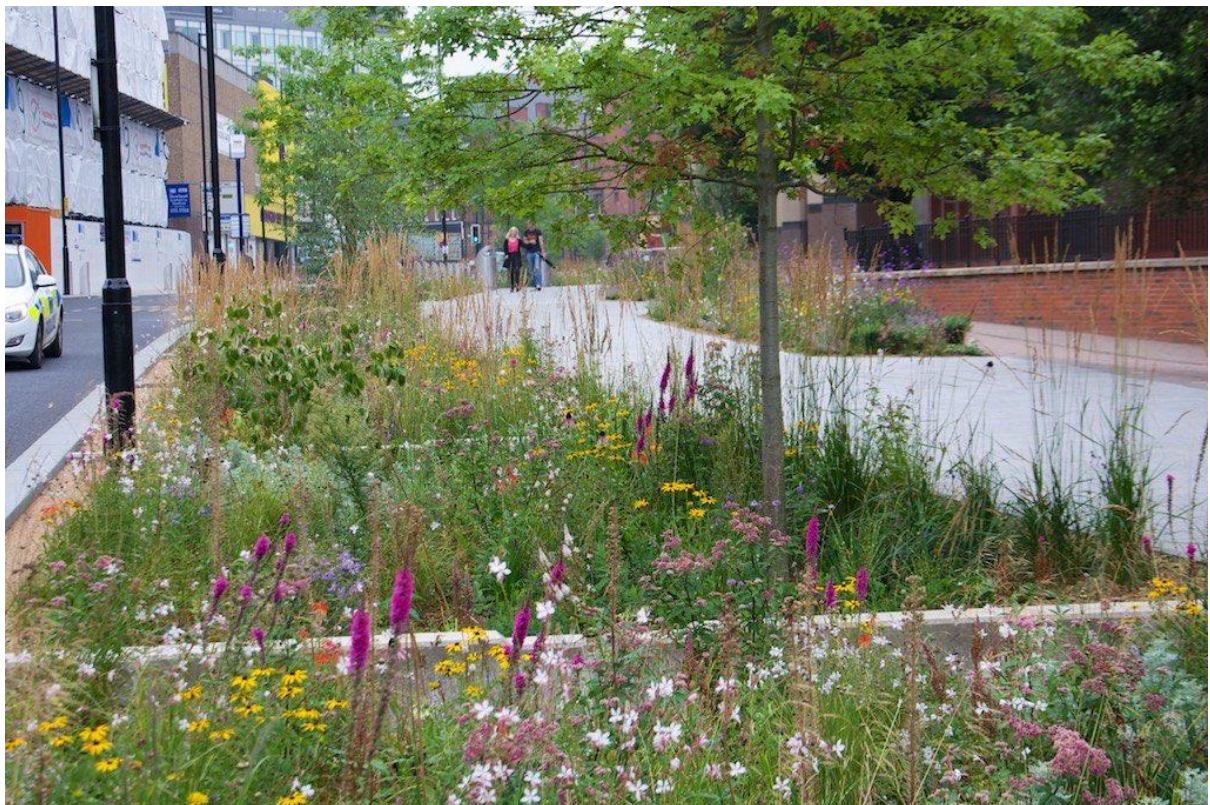
Obr. 3 Dešťový záhon – Úprava stromořadí v dešťovém záhonu
