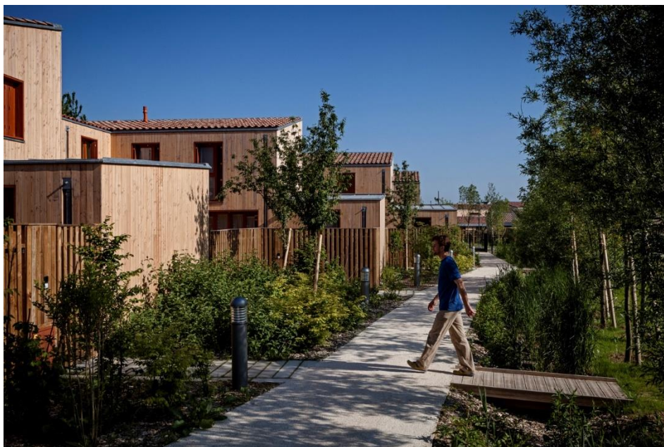
Obr. 6 Pěší lávka přes průleh
