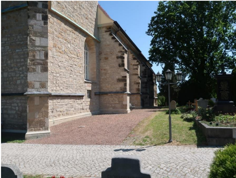
Obr. 13 Jižní strana s podzemním utěsněním půdy
