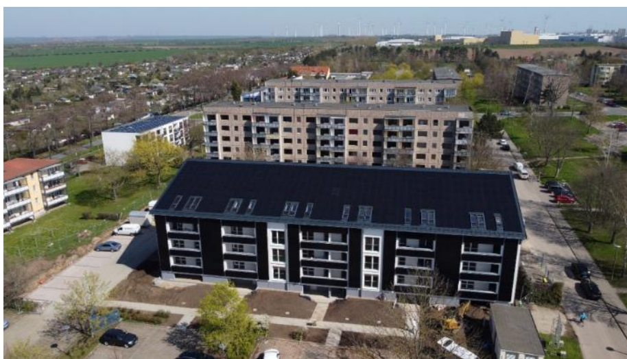
Obr. 9 Včera starý panelák v Aschersleben, dnes energeticky vysoce soběstačný bytový dům s 22 bytovými jednotkami
