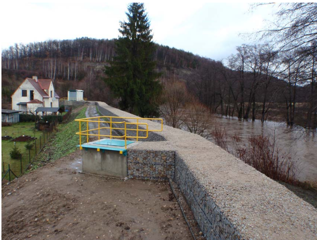
Obr. 2 Navýšení zemní protipovodňové hráze drátokošovou stěnou s železobetonovým těsnicím jádrem (foto Ing. Jiří Leitgeb, CSc.)
