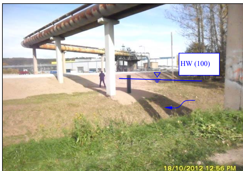
Obr. 4 Nová protipovodňová hráz s ochranou sloupů dálkového teplovodu proti nárazu
