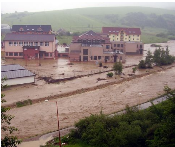
Obr. 2 Havarijná situácia vyvolaná záplavami. [11]
