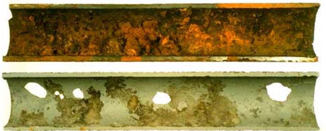
Obr. 4 Plne perforovaná stena vodovodného potrubia vplyvom korózie [14]
