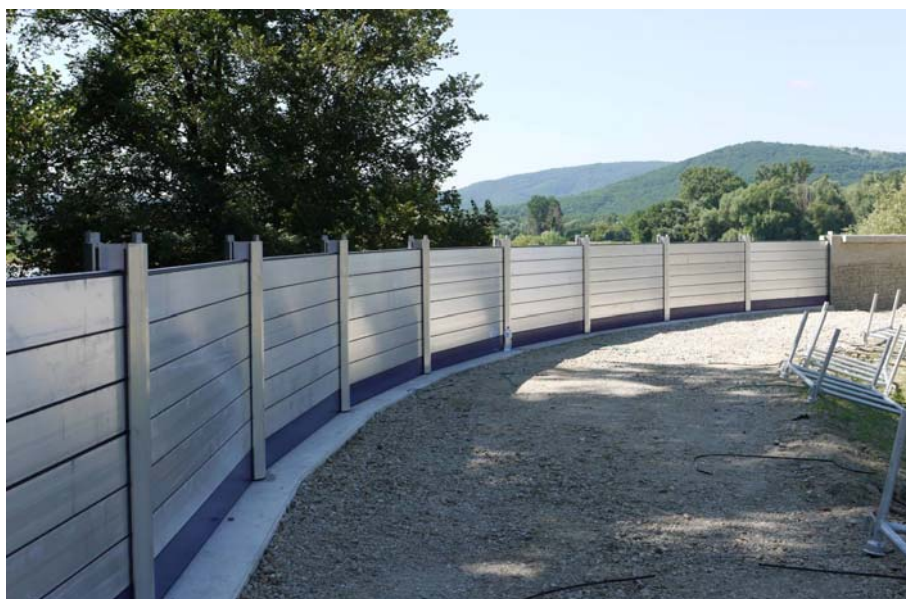
Obr. 3 Mobilné hradenie v úseku aktivity 4, chrániace v povodňovej situácii Devín
