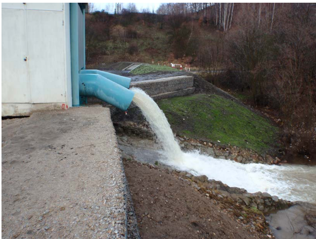
Obr. 3 Přečerpávání vody přes protipovodňovou hráz ze Pstružného potoka do řeky Ohře při stavu bdělosti (foto Ing. Jiří Leitgeb, CSc.)
