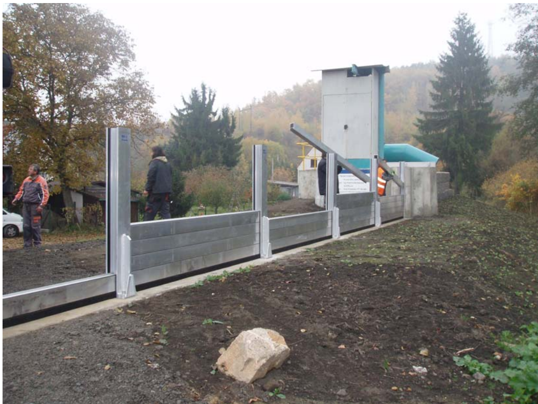
Obr. 4 Stavba mobilních hradidel v úseku přejezdu protipovodňové hráze v místě u „vodáckého tábořiště“ (foto Ing. Kateřina Bařtipánová)
