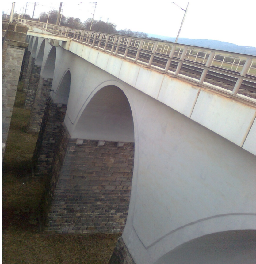
Obr. 3 Mosty na trati Ostrava – Přerov, žst. Hranice n. M. (II. tranzitní železniční koridor)
