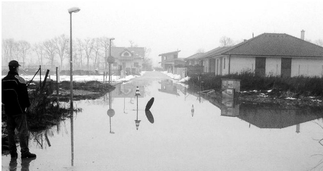
Obr. 1 Kolaps kanalizačního systému Chorvátском Grobe v důsledku topení sa snehu, působené nesprávným návrhom kanalizácie a nedostatočnou kapacitou čerpadel
