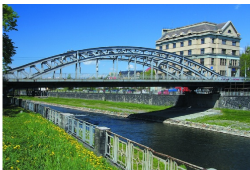
Obr. 2 Opěrné nábrežní zdi v centru Města Ostravy, obvyklý průtok řeky Ostravice
