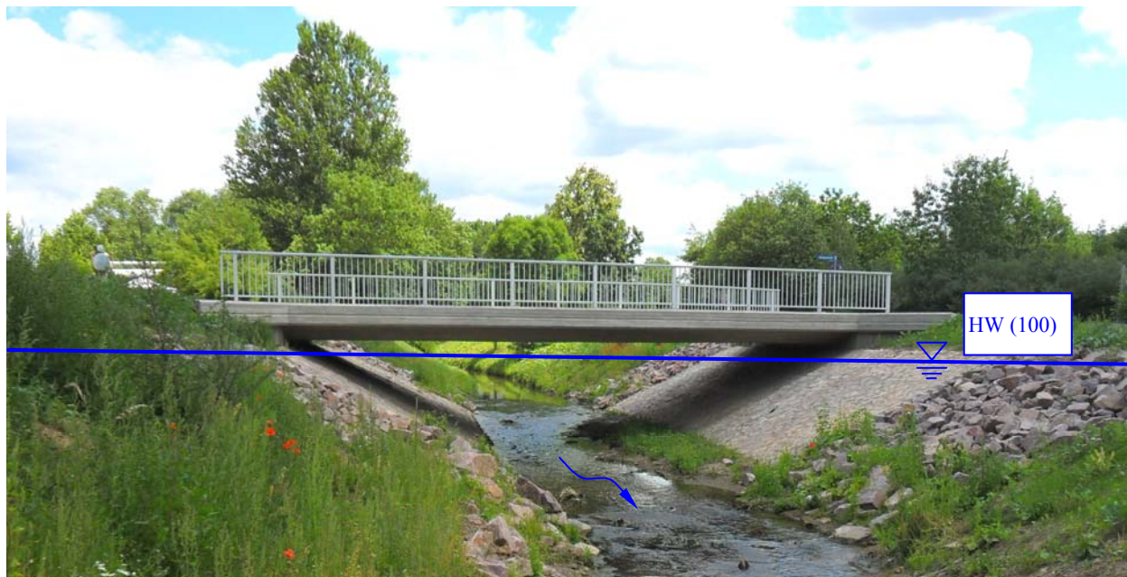
Obr. 3 Nový most z předpjatého betonu – pohled proti proudu
