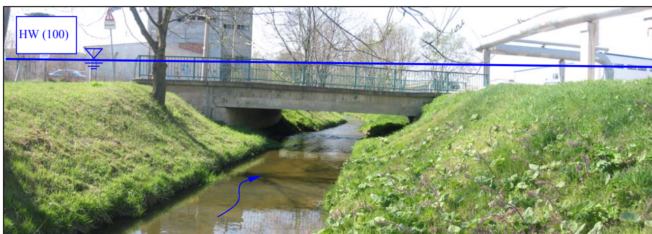
Obr. 2 Překážka při povodni – starý most přes říčku Brahme při pohledu po proudu
