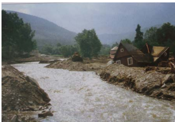
Obr. 3 Zničená zástavba obce na toku řeky Odry při povodni v roce 1997[ 2]
