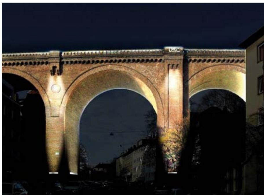
Obr. 4 Renovovaný a osvětlený viadukt přes ulici Steinweg (dotační oblast III)
