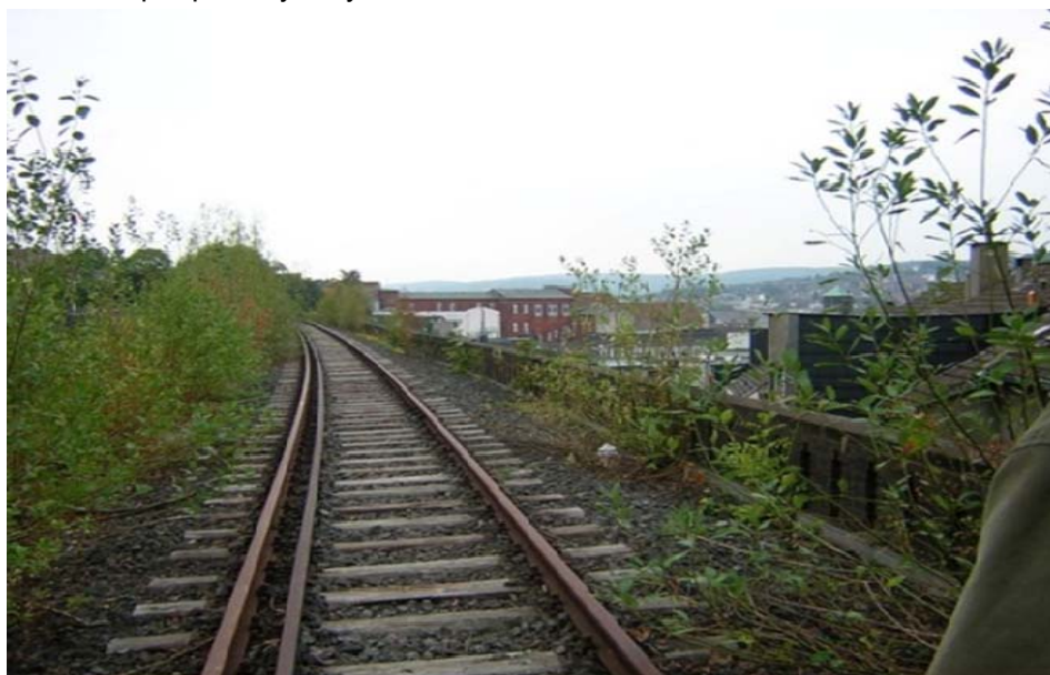
Obr. 1 Bývalá a zrušená Rýnská železniční trať ve Wuppertalu
