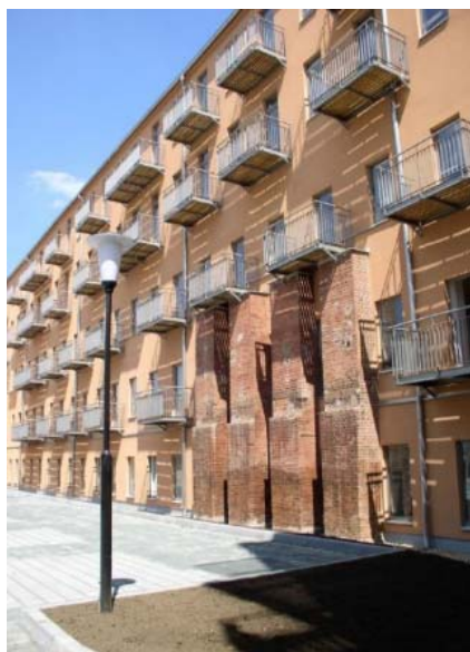
Obr. 6 Dvůr po přestavbě
