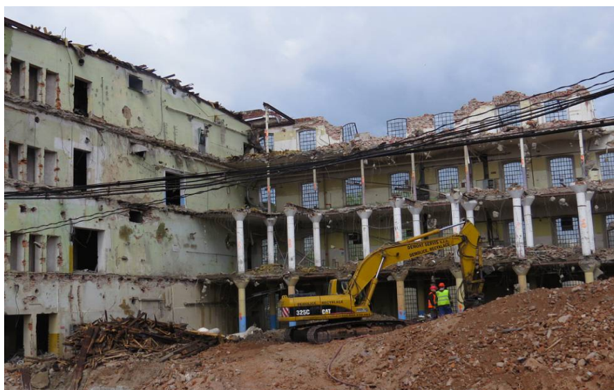
Obr. 4 Demolice budovy Landsbergerovy přádelny
