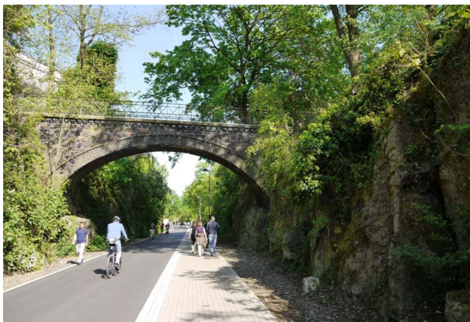
Obr. 3 Dokončená stavba komunikací v prostoru ulice Sonnabendstraße (dotační oblast III)
