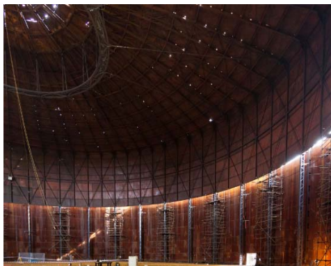
Obr. 16 1. etapa – zvednutí zvonu
