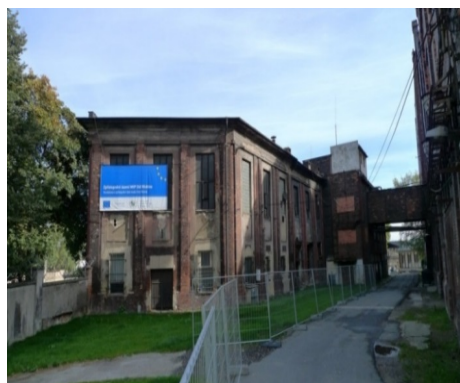
Obr. 38 Rozvodna – stávající stav
