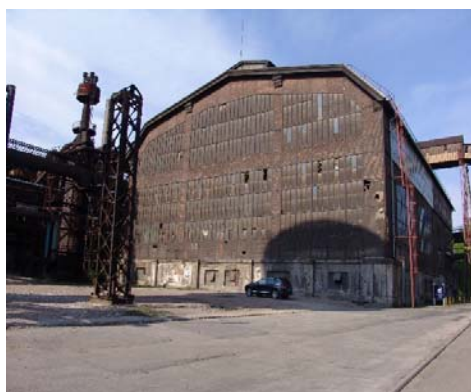
Obr. 22 VI. Ústředna – původní stav, rok 2010
