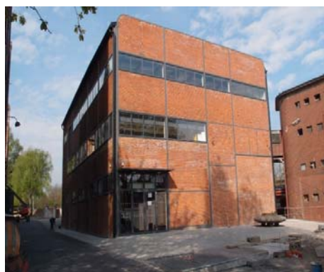
Obr. 43 Budova skladu MTZ – Cineport
