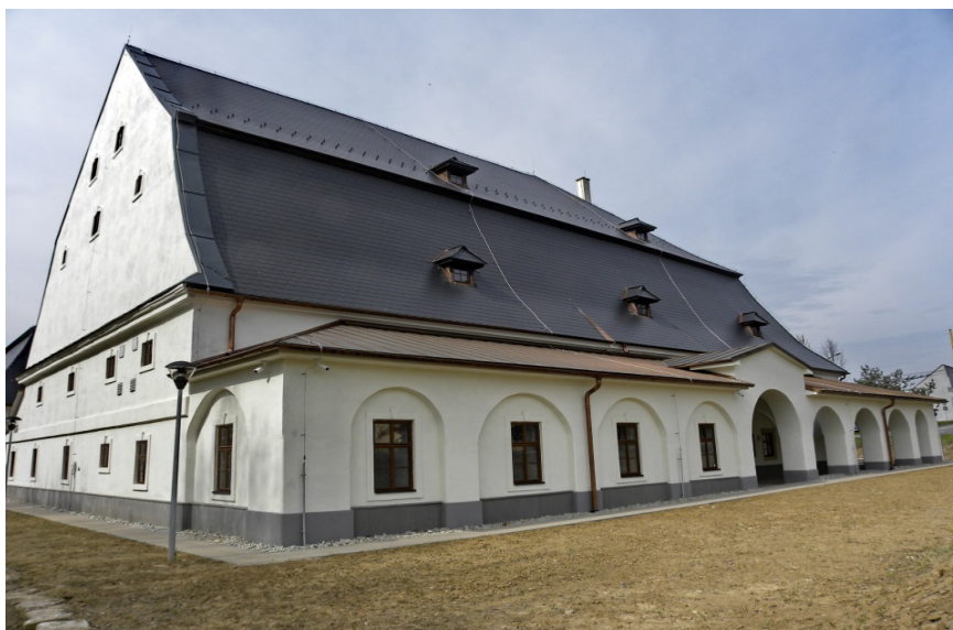
Obr. 6 Rekonštruovaný Sklad soli (východný pohľad)
