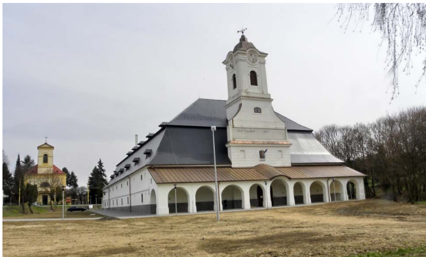
Obr. 5 Rekonštruovaný Sklad soli (západný pohľad)
