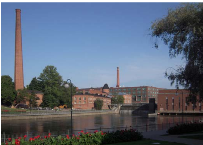
Obr. 13 Ve většině evropských měst dnes už nalezneme příklady, které dokládají přínosy vtažení konverzí industriálních staveb do urbanismu soudobého města. Z těch mnoha vybíráme jen několik pro podchycení jejich různorodosti. K nejvýše hodnoceným patří nové městské centrum z areálů továren v Tampere, Finsko
