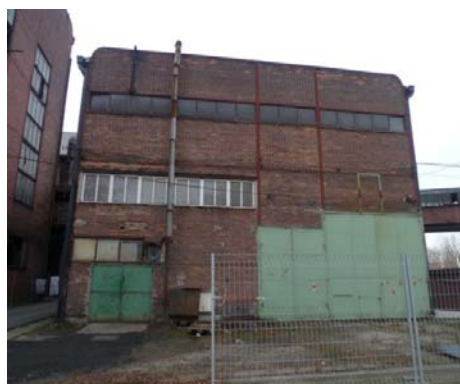
Obr. 42 Budova skladu MTZ – stávající stav
