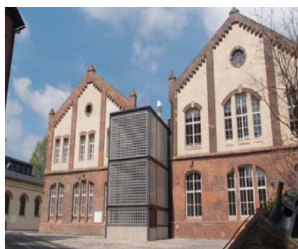
Obr. 47 Staré koupelny – Brick house
