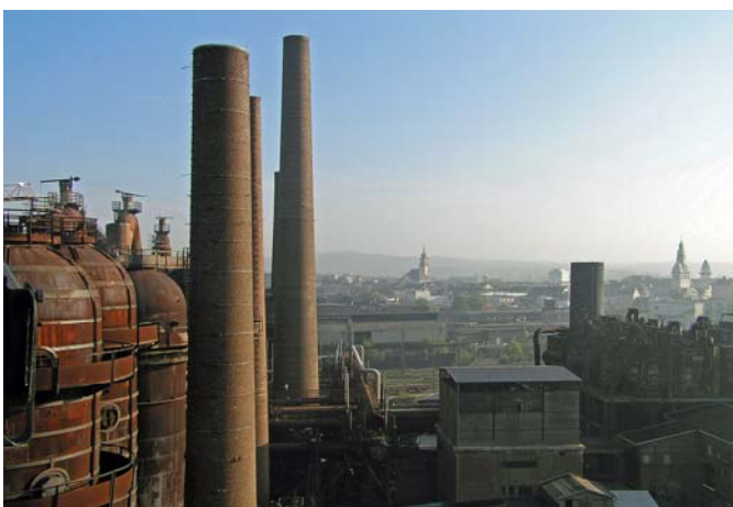
Obr. 4 Bývalá železářská huť je hlavní atrakcí německého města Völklingen
