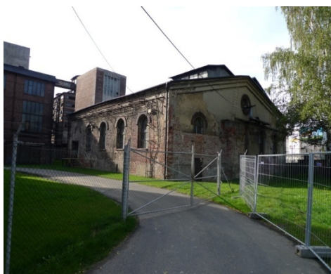
Obr. 52 Kompressorovna – stávající stav
