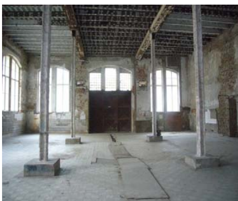
Obr. 48 Staré koupelny – stávající interiér
