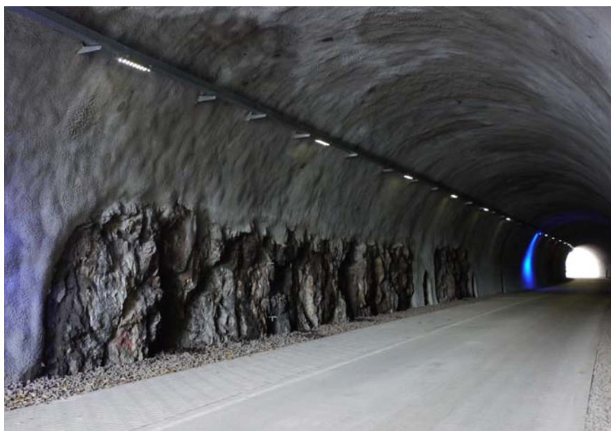
Obr. 6 Renovovaný tunel Engelnberg s dokončenou komunikací (dotační oblast II)
