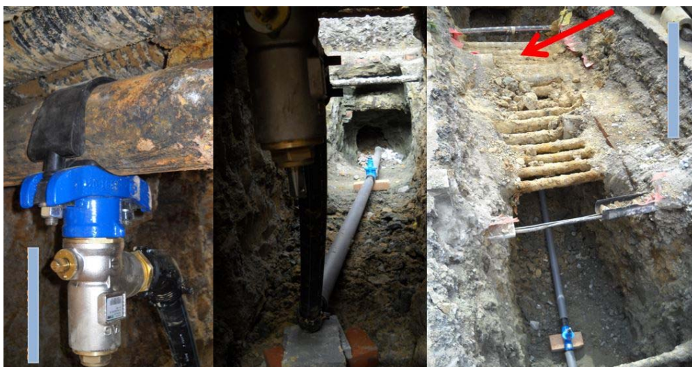
Obr. 7 Improvizace při realizaci vodovodní přípojky Zdroj: vlastní
