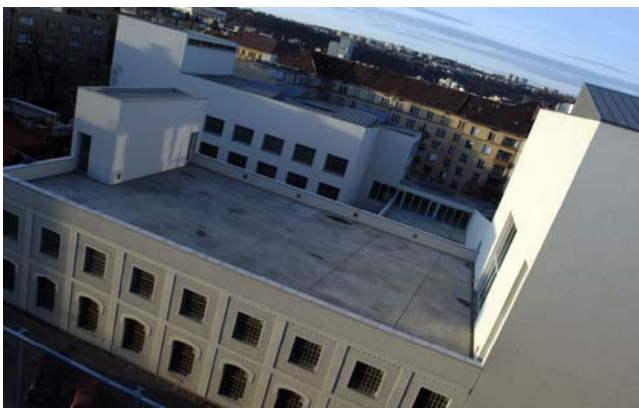
Obr. 24 Galerie Dox v bývalé strojírenské továrně
