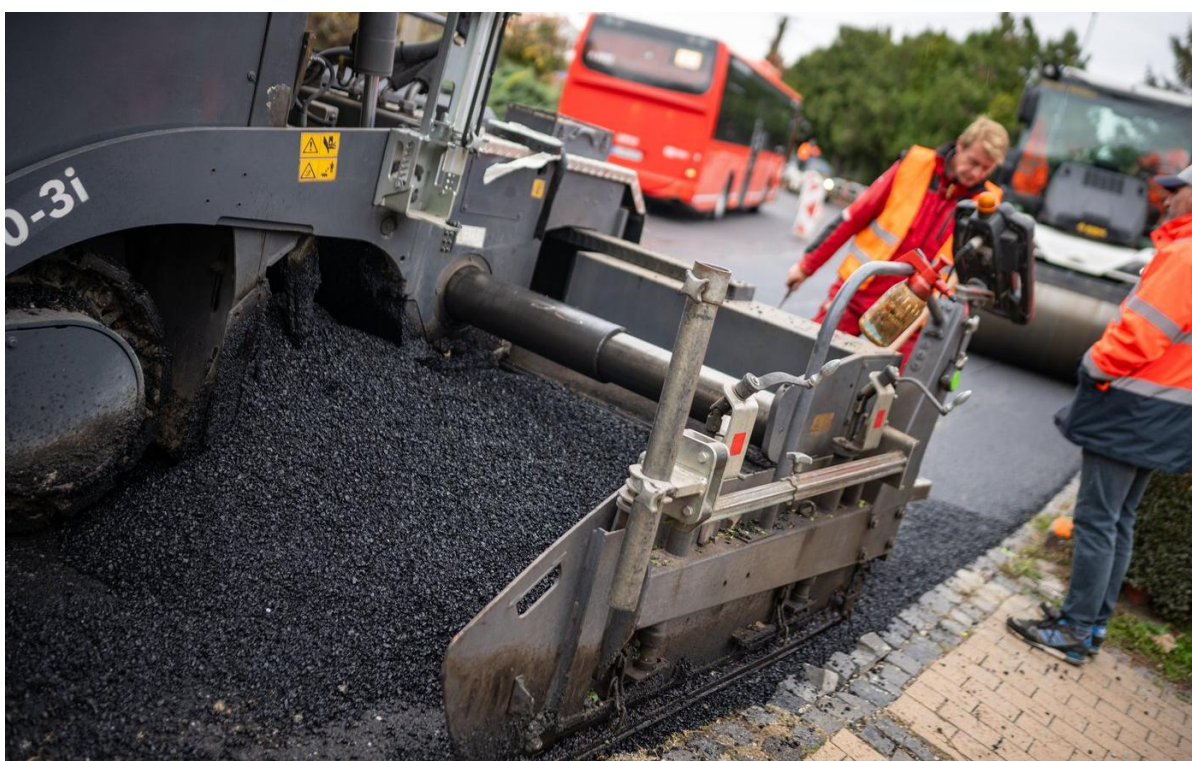
Obr. 4 Detail pokládky zmesi SMA s prísadou Reneso Fibers, v pozadí autobus linky B1D prechádza obcou Malinovo. Fotografia: SCBSK
