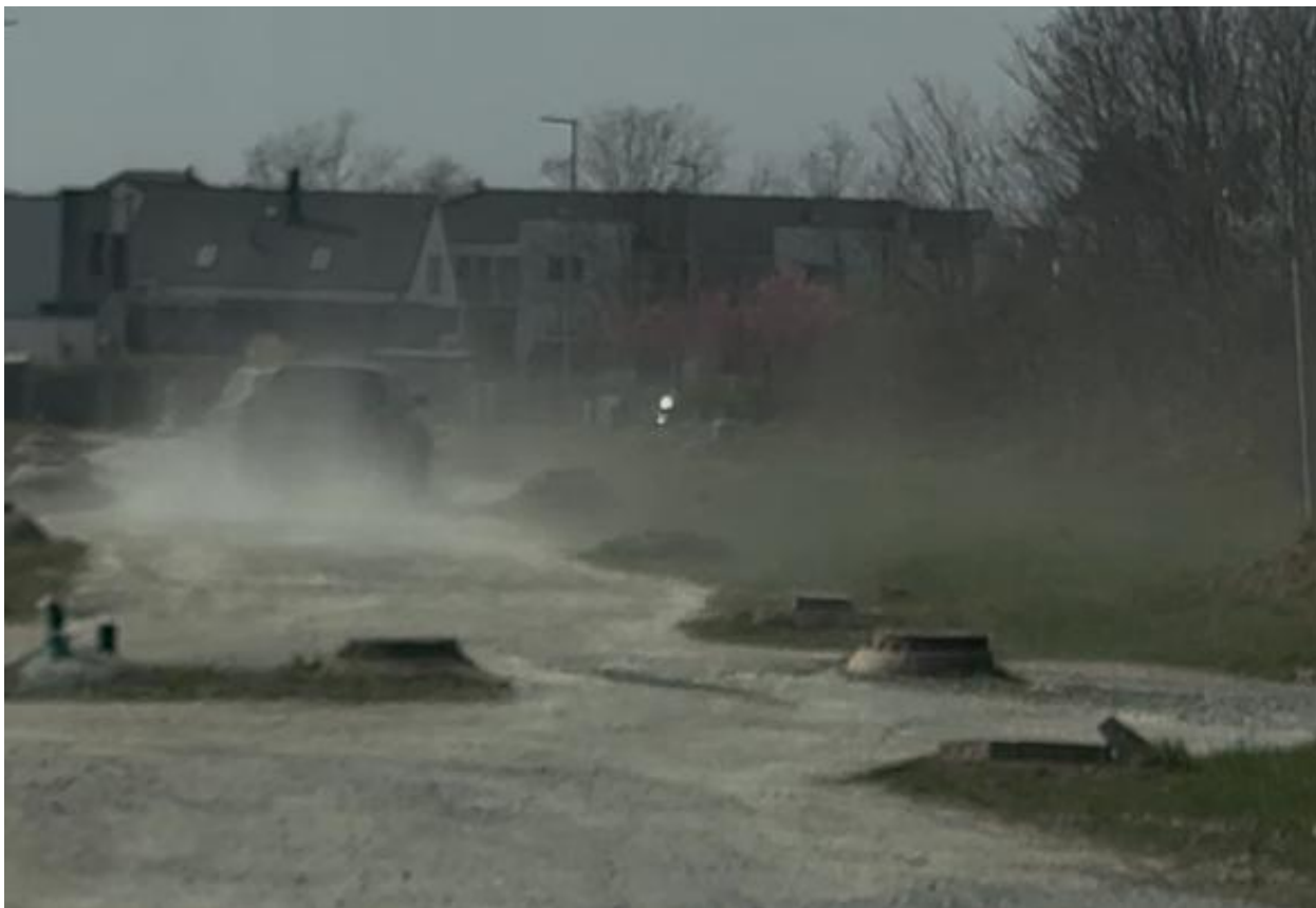
Obr. 1 Prášící nezpevněný povrch komunikace v Szombathely během provozu
