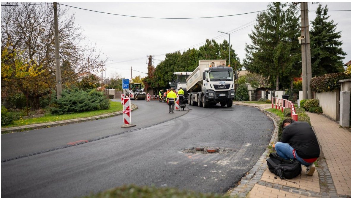
Obr. 5 Celkový pohľad na rekonštruovaný úsek cesty II/121 v Malinovom počas hutnenia asfaltobetónovej zmesi. Fotografia: SCBSK
