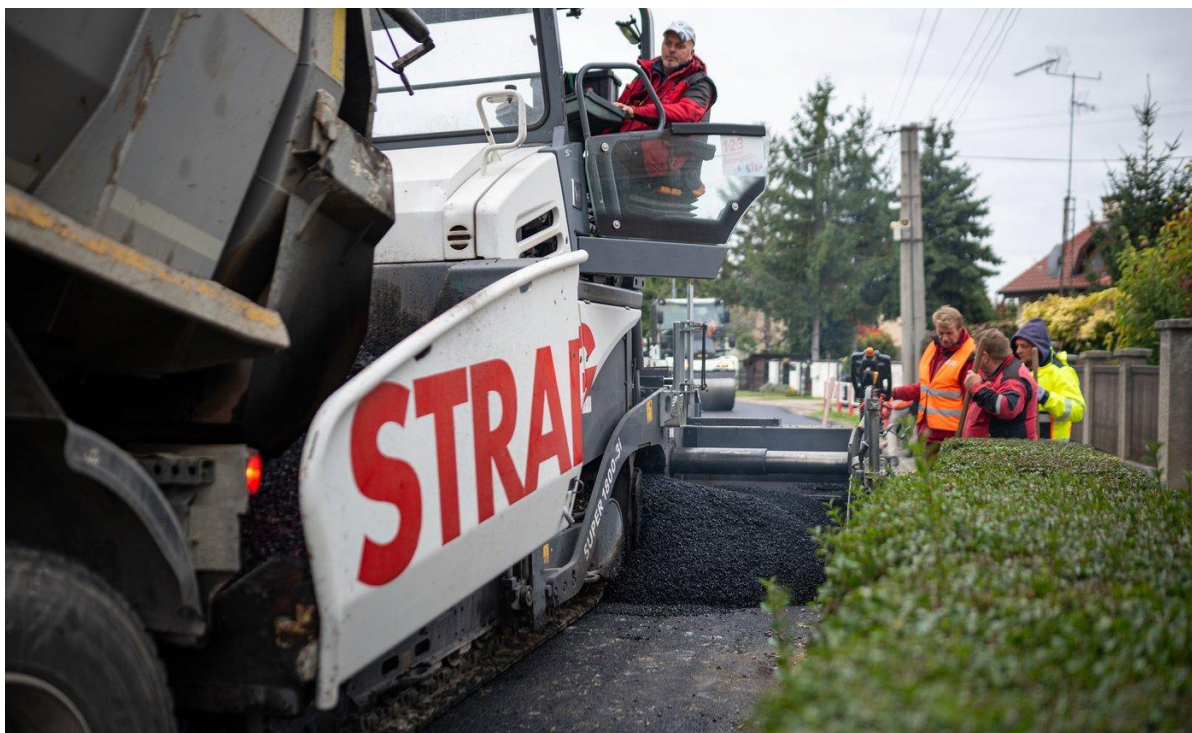
Obr. 3 Finišer STRABAG Super 1800-3i pri pokládke asfaltobetónovej zmesi SMA s prísadou Reneso Fibers, cesta II/121 Malinovo, 27. 10. 2025. Fotografia: SCBSK
